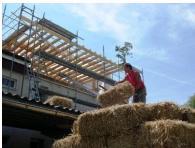
Strohballen für die Lehmwände im Dachstock
